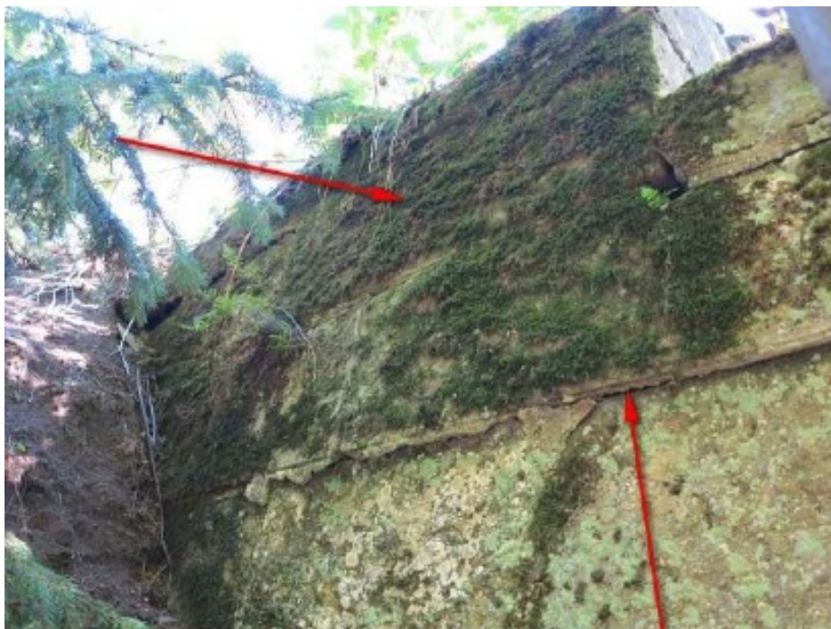
Vysunuté kameny na O2 křídlo vlevo
